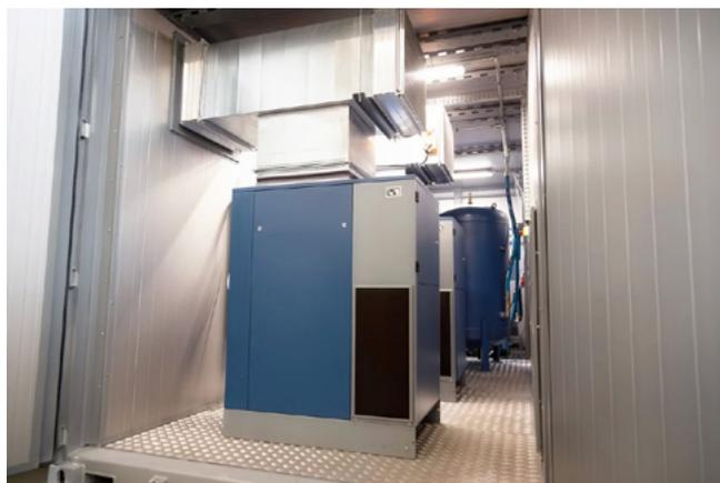
Почти **96% энергии**, которой снабжается компрессор, можно регенерировать в виде потока теплого воздуха. Наиболее эффективным и простым способом использования излучаемого тепла является использование его для отопления помещений.
