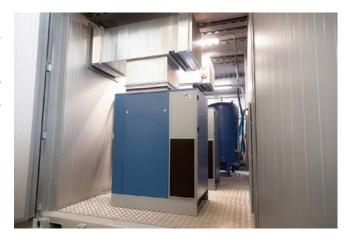
Почти 96% **энергии**, которой снабжается компрессор, можно регенерировать в виде потока теплого воздуха. Наиболее эффективным и простым способом использование излучаемого тепла является использования его для отопления помещений.
